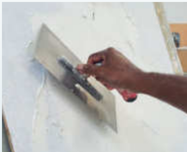
1. vorbereitete Fläche mit Kalkglätte überziehen
