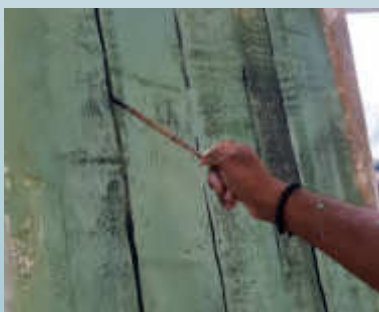
7. Fugen mit einem Strichzieher individuell nachziehen, trocknen lassen.
