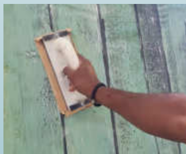
8. Fläche partiell mit Körnung 150 nachschleifen.
