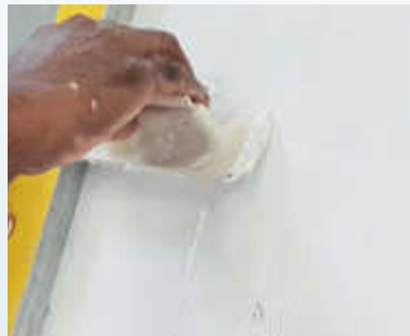
2. Kalkglätte mit dem Maserboy strukturieren.
