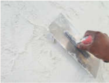
1. Vorbereitete Fläche mit Mörtel grob überziehen
