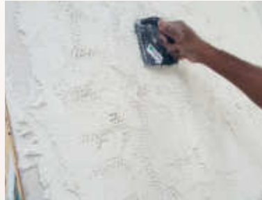
2. Mörtel mit dem Istinto Strukturierer...
