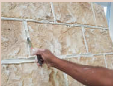
10. Anschließend mit einem Fugeisen...
