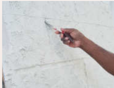
5. Fugen mit einer Wasserwaage anzeichnen und anschl. mit einer Fugenkelle rauskratzen
