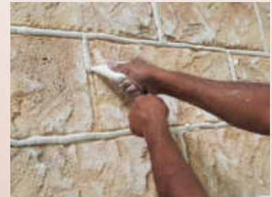
9. Fugen mit Mörtel ausfügen.
