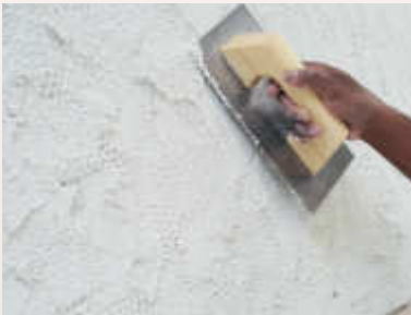
4. Angetrockneten Mörtel mit einer Zahnkelle partiell „sägen“
