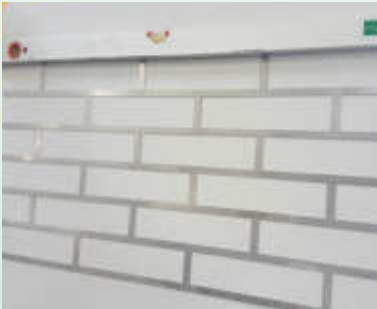
Edelstahlschablone auf dem vorbereiteten Untergrund mit einer Wasserwaage ausrichten und leicht mit Nägeln fixieren
