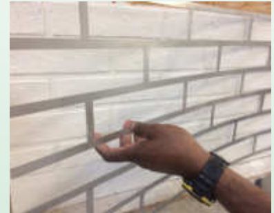
Schablone aus dem frischen Mörtel vorsichtig entfernen
