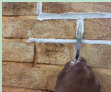
Mit einem Stukkateur-Eisen oder einer Fugenkelle nacharbeiten und den Mörtel glätten
