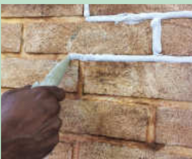
Fugen mit verdünntem Mörtel ausspritzen
