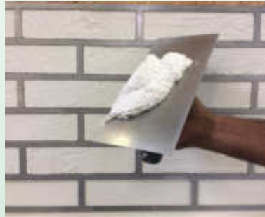
Fläche vollständig mit Mörtel dünn überziehen
