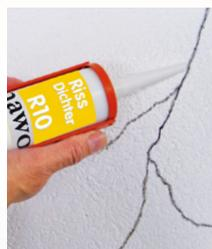
Fassadenrisse sind nicht nur ein optischer Mangel. Durch sie kann Feuchtigkeit in das Mauerwerk eindringen und dort Schäden verursachen. Um dies zu verhindern, müssen diese Risse fachmännisch abgedichtet werden.
